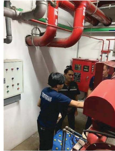
เจ้าหน้าที่ฝ่ายช่างตรวจสอบใช้ระบบปั้มน้ำดับเพลิง
