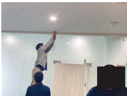
เจ้าหน้าที่ฝ่ายช่างตรวจสอบเช็คอุปกรณ์ป้องกัน และแจ้งเหตุอัคคีภัย
