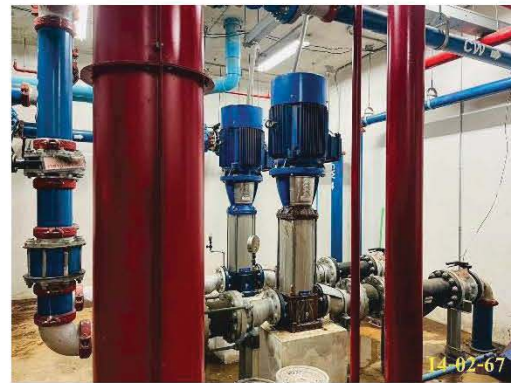
ถังเก็บน้ำใต้ดิน พร้อมเครื่องสูบน้ำทาวเวอร์ 1
